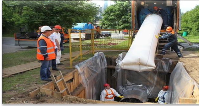
Նկ. 5. Նորոգվող խողովակաշարի մեջ էպօքսիդային խեժով պատված ճկախողովակի անցկացում
