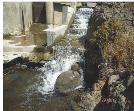
Նկար 2. Նախագծի համաձայն ճիշտ կառուցված ձկնանցարանը:
