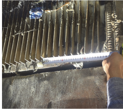
Նկար 3. Գլխամասում բացակայում են ձկնապաշտպան ցանցավանդակները:
