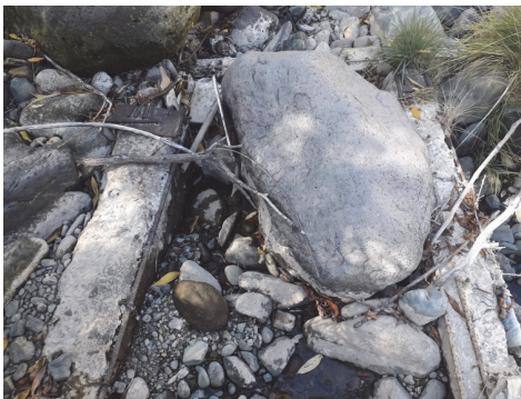
Նկար 1. Կառուցված ձկնանցարանը նախագծին չի համապատասխանում և չի կարող ծառայել իր նպատակին:
